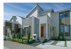
第10回／竣工検査
