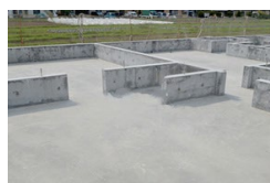
第3回／基礎完成検査
