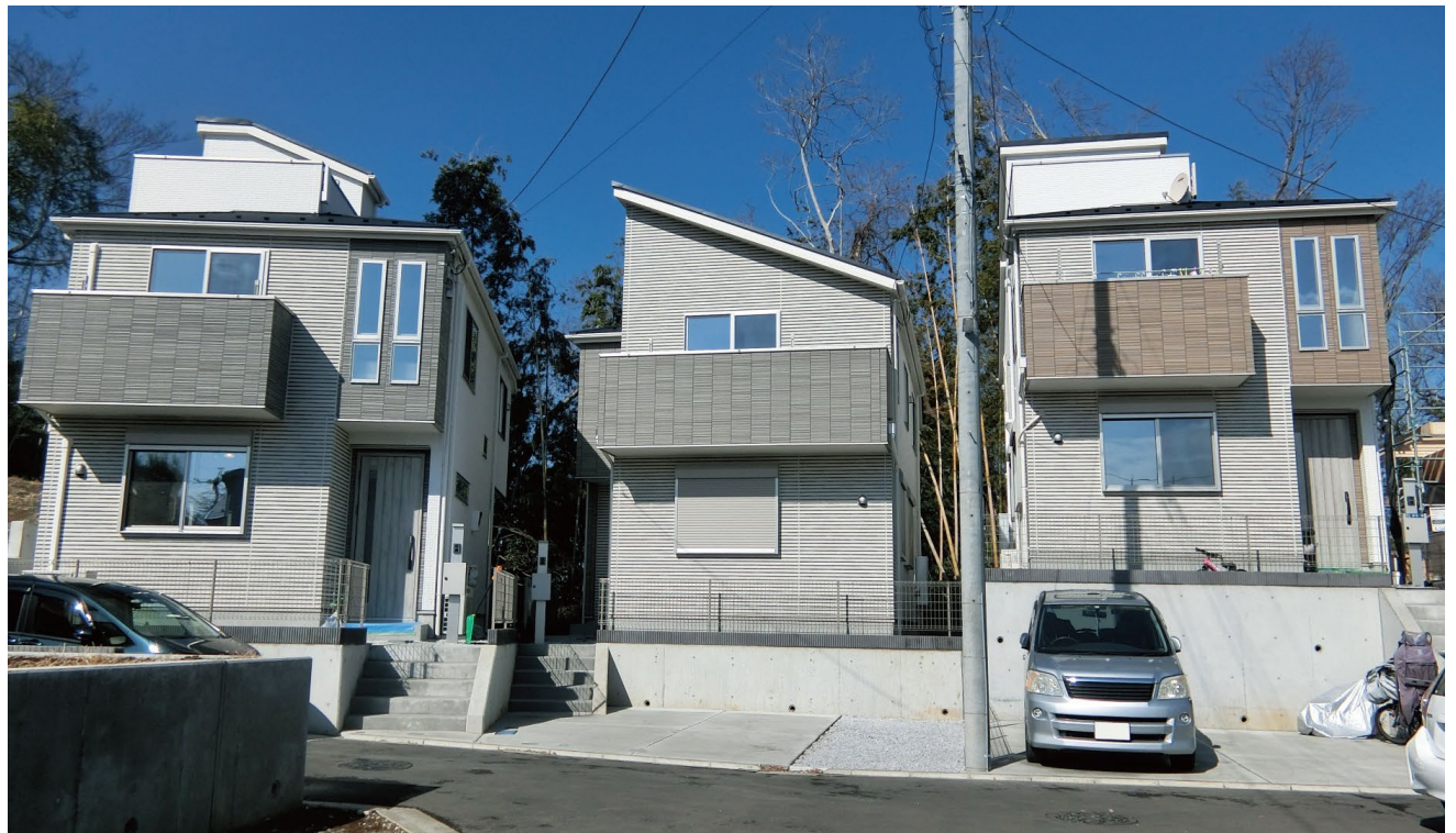
▲ 建物外壁までの距離の制約を逆手に取り、1棟1棟に広々とした庭と2台分の駐車場を設けました。
