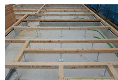
第4回／土台検査
