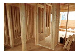
第5回／上棟(金物緊結)検査
