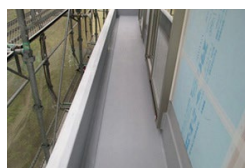
第7回／防水検査
