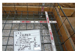
第1回／配筋検査
