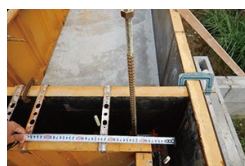
第2回／アンカー検査
